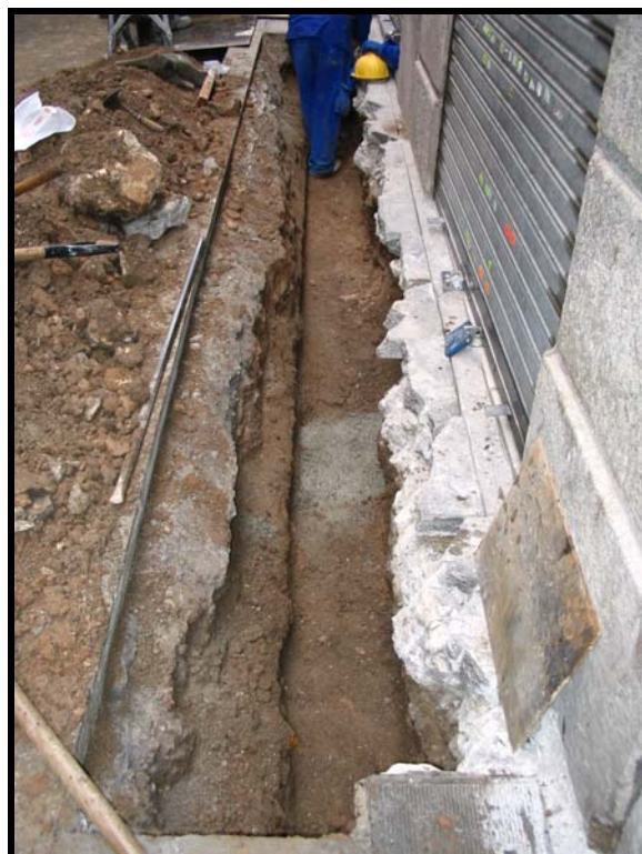
Foto 18. Vista de les obres a l'alçada de la finca nº 24, on s'observa el servei elèctric que travessa tota la rasa.
