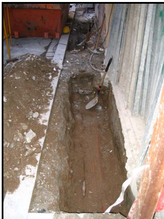
Foto 10. Vista de la rasa en el quart tram a l'alçada del nº26, on s'observen els nous serveis d'electricitat, i a l'esquerra el servei d'electricitat que travessa la des del seu inici.
