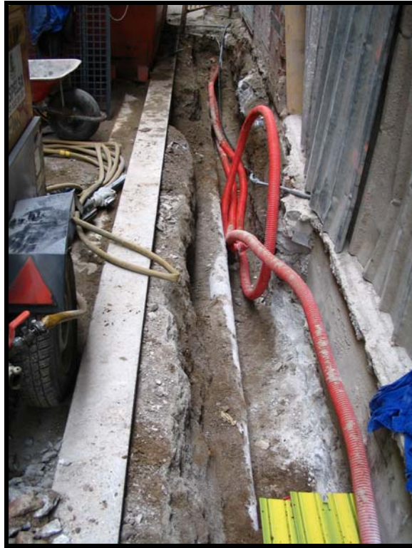
Foto 15. Vista del servei elèctric que travessa tota la rasa a l'alçada del nº 26.
