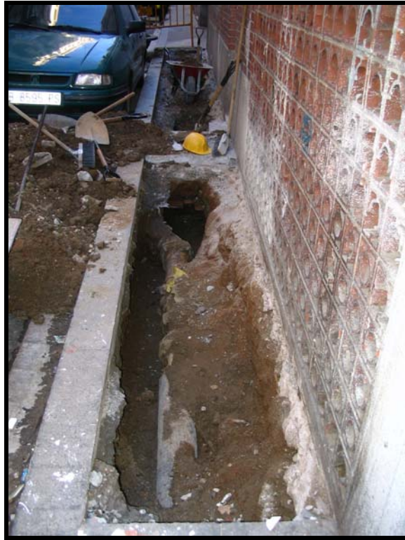
Foto 7. Vista general dels dos trams de la rasa en el seu inici en sentit sud. Es pot observar la canalització de gas desviant-se cap a l'oest.
