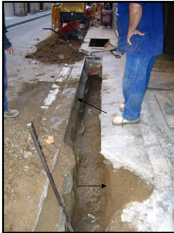
Foto 19. Vista de les obres a l'alçada de la finca n°22 on s'observen dos serveis a tocar de cada perfil de la rasa.
