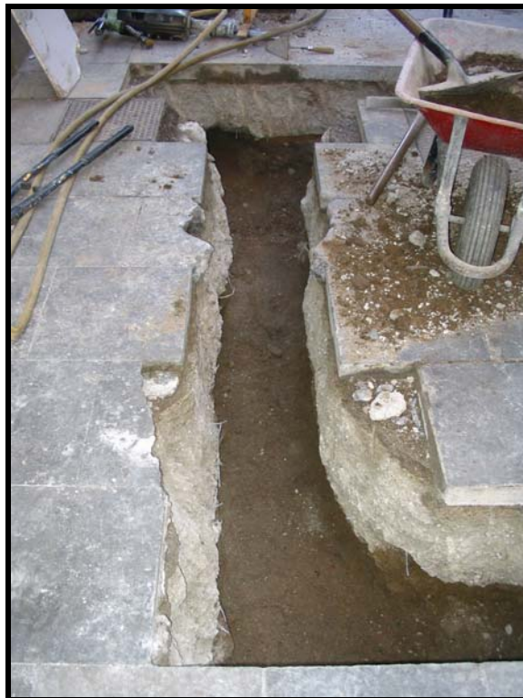
Foto 22. Continuació de l'ampliació situada a l'inici de la primera cata.
