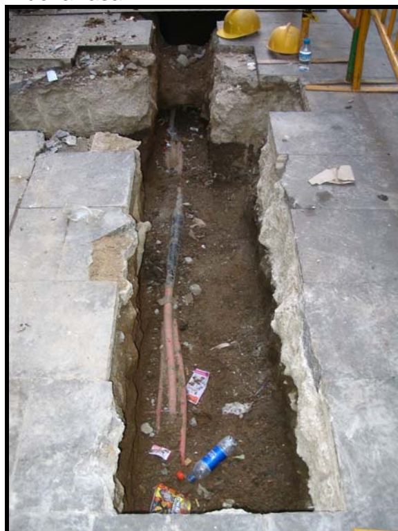
Foto 20. Ampliació situada a l'inici de la primera cata. Es pot observar la presència dels serveis elèctrics els quals eren objecte d'aquesta intervenció urbanística.
