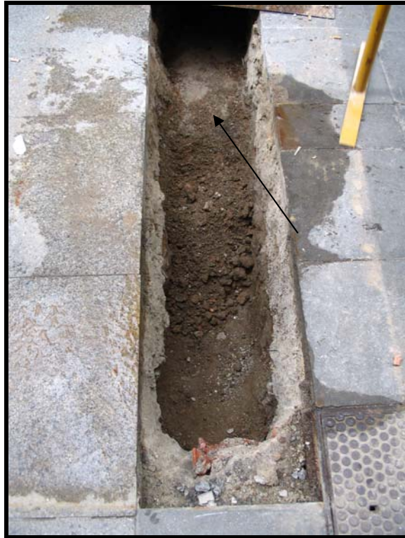
Foto 3. Rasa realitzada a l'inici dels treballs al c/ Sant Bertran. S'observa el servei de clavegueram actual.
