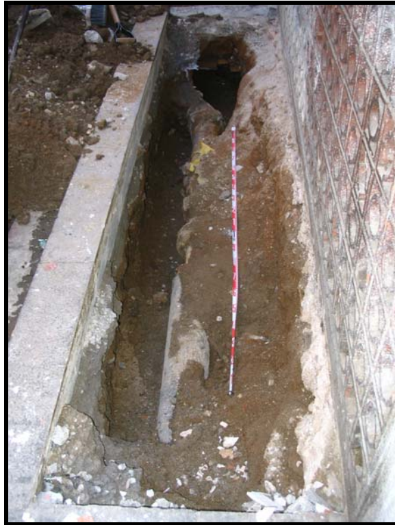
Foto 5. Inici de la rasa en sentit sud al carrer Santa Madrona, s'observa la gran canalització elèctrica que travessa la rasa i trenca en direcció a l'oest.
