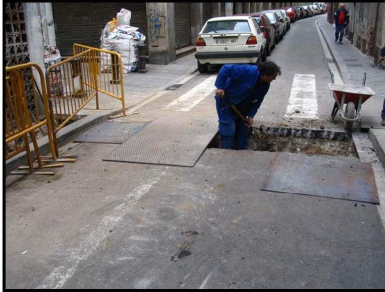
Foto 23. Realització dels treballs al tram corresponent a la circulació de vehicles.
