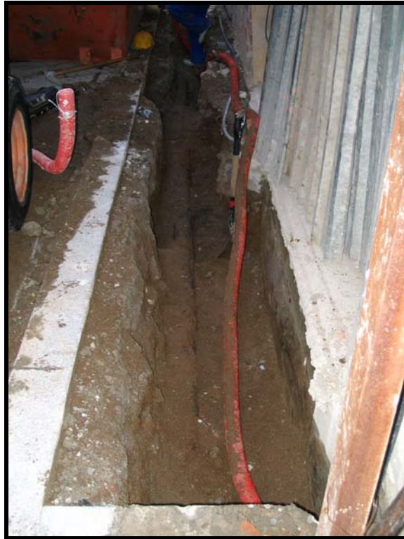
Foto 13. Vista de la rasa a l'alçada de la finca nº 26. S'observen els nous serveis instal·lats amb anterioritat a aquesta intervenció, i a la banda dreta, els encofrats dels fonaments.
