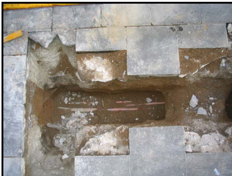
Foto 2. Vista zenital de l'inici de la rasa al c/ Sant Bertran, es pot observar l'anterior servei de cablejat elèctric, i a la dreta de la imatge, el servei UE 1006, una canalització d'aigua que abasteix els habitatges del carrer.
