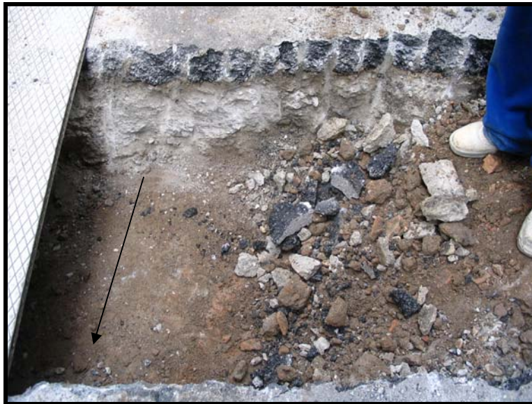
Foto 24. Localització del servei de clavegueram actual, al tram de la rasa corresponent a la circulació dels vehicles.
