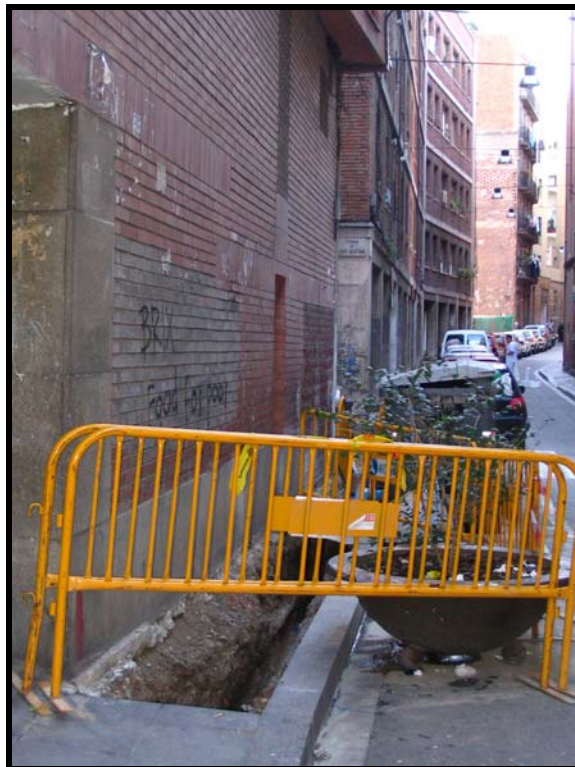
Foto 14. Vista de les obres a l'inici de la rasa al c/ Santa Madrona (sentit Nord).
